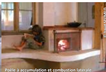
Poêle à accumulation et combustion latérale
